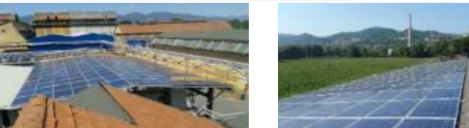
IMPIANTI FOTOVOLTAICI PER PRODUZIONE DI ENERGIA ELETTRICA DA FONTI RINNOVABILI
